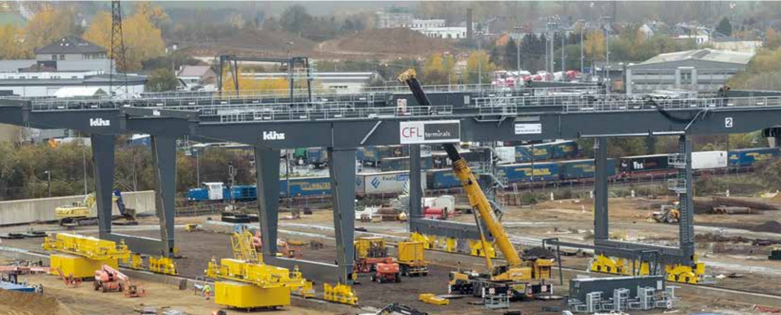
Le montage des deux nouvelles grues s'est étalé sur 2 mois.
